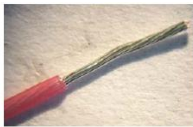
Рис.2 Подготовка кабеля
